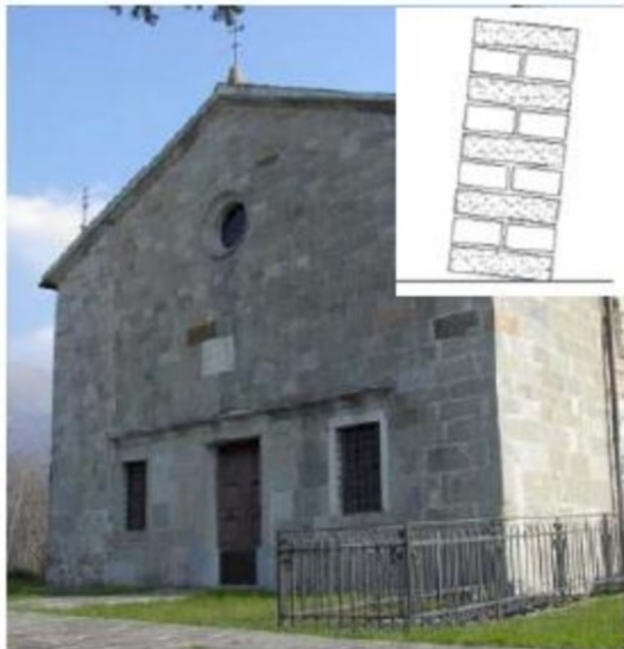
Muratura in pietra squadrata a tessitura regolare
